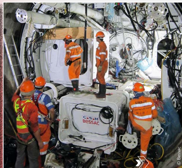
Le TDM (Tunnel Dismantling Machine) utilisé à Hong Kong pour démonter les voussoirs d'un tunnel
